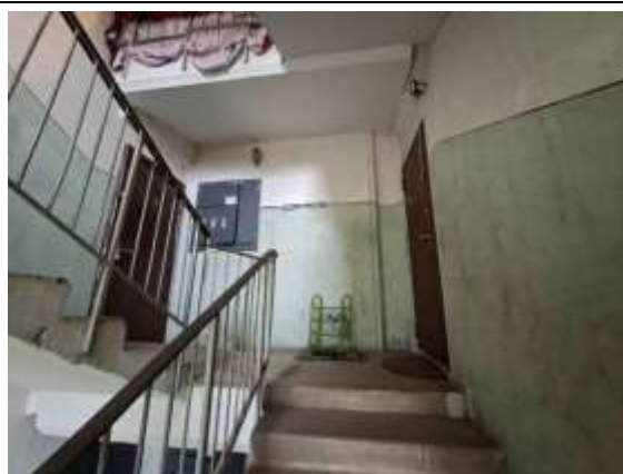
2.stāva kāpņu telpa
